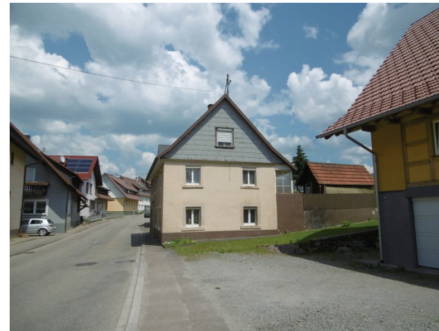
Hauptstraße 114 (Sanierungszuschuss für Abbruch)
